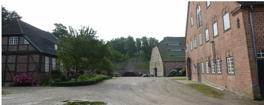
Wohnhaus und Wirtschaftsgebäude Gut Siggen
