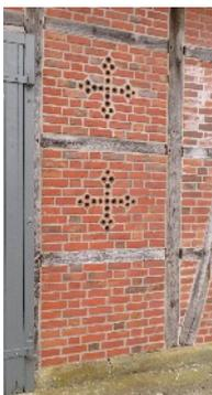
*Hauselement mit Lüftungsschlitzen in Kreuzform aus Tonröhren.*
